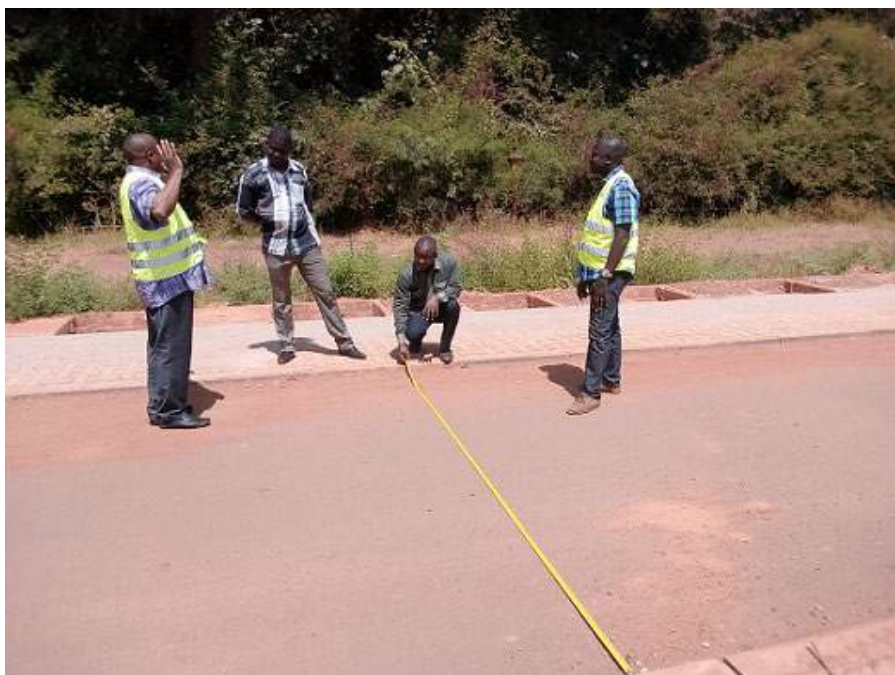
Exercice de la mesure d'une section de la RN4 à proximité du Parc urbain Bangrénéwéogo
