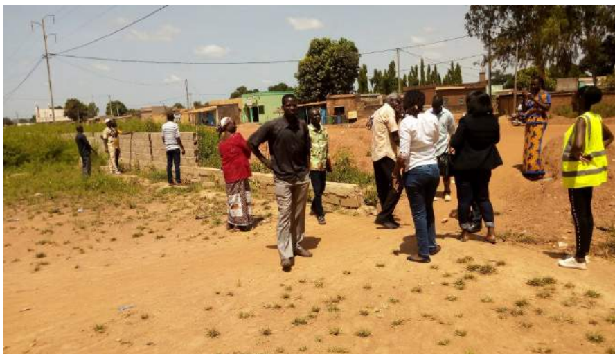
Les points focaux de Gomboussougou s'opposent à la construction d'un mur de clôture sans fondation d'une école
