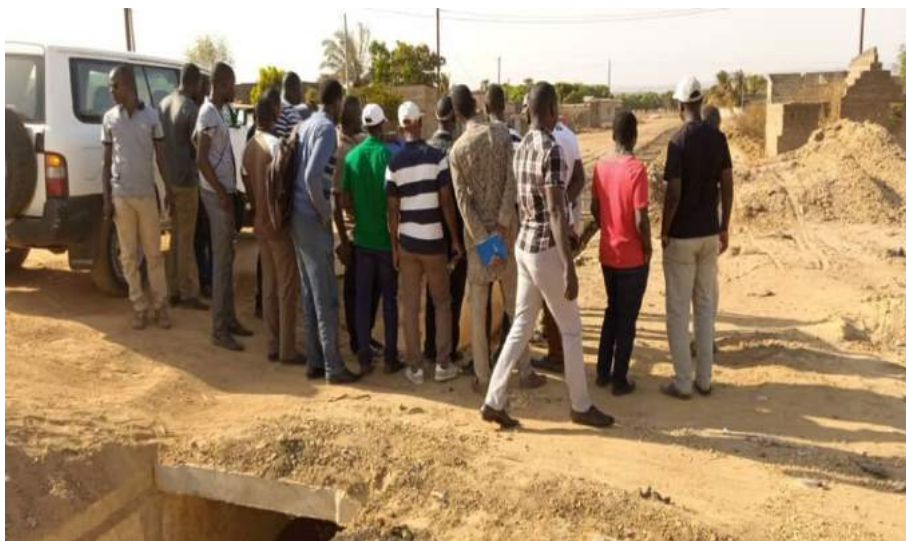
Visite des chantiers avec les acteurs de mise en œuvre du projet à Banfora
